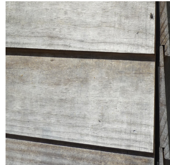
Raue gesägte Oberflächen sind der Aufbauschicht zuträglicher
