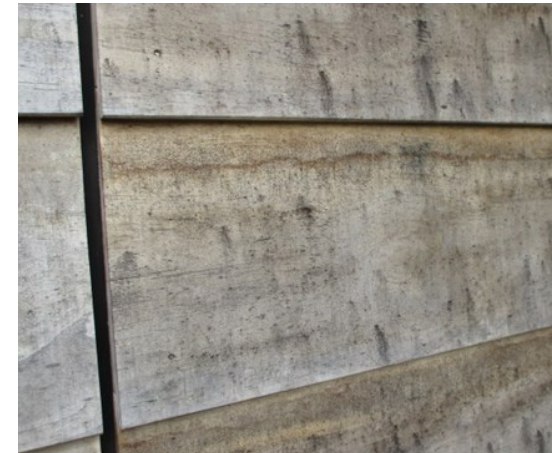
Raue gesägte Oberflächen sind der Aufbauschicht zuträglicher
