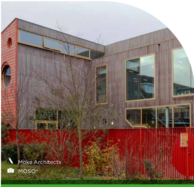
IKC de Zeven Zeeën Grundschule Foto 5 Jahre nach der Installation (320 m 2 ) Amsterdam, Niederlande
